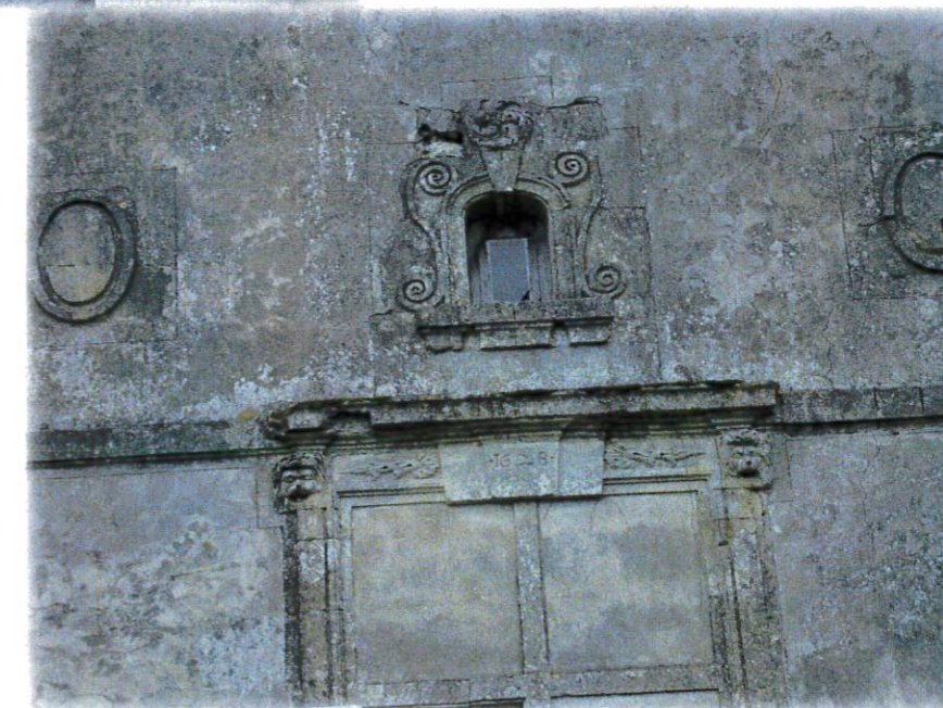
Haut de fenêtre date 1628
