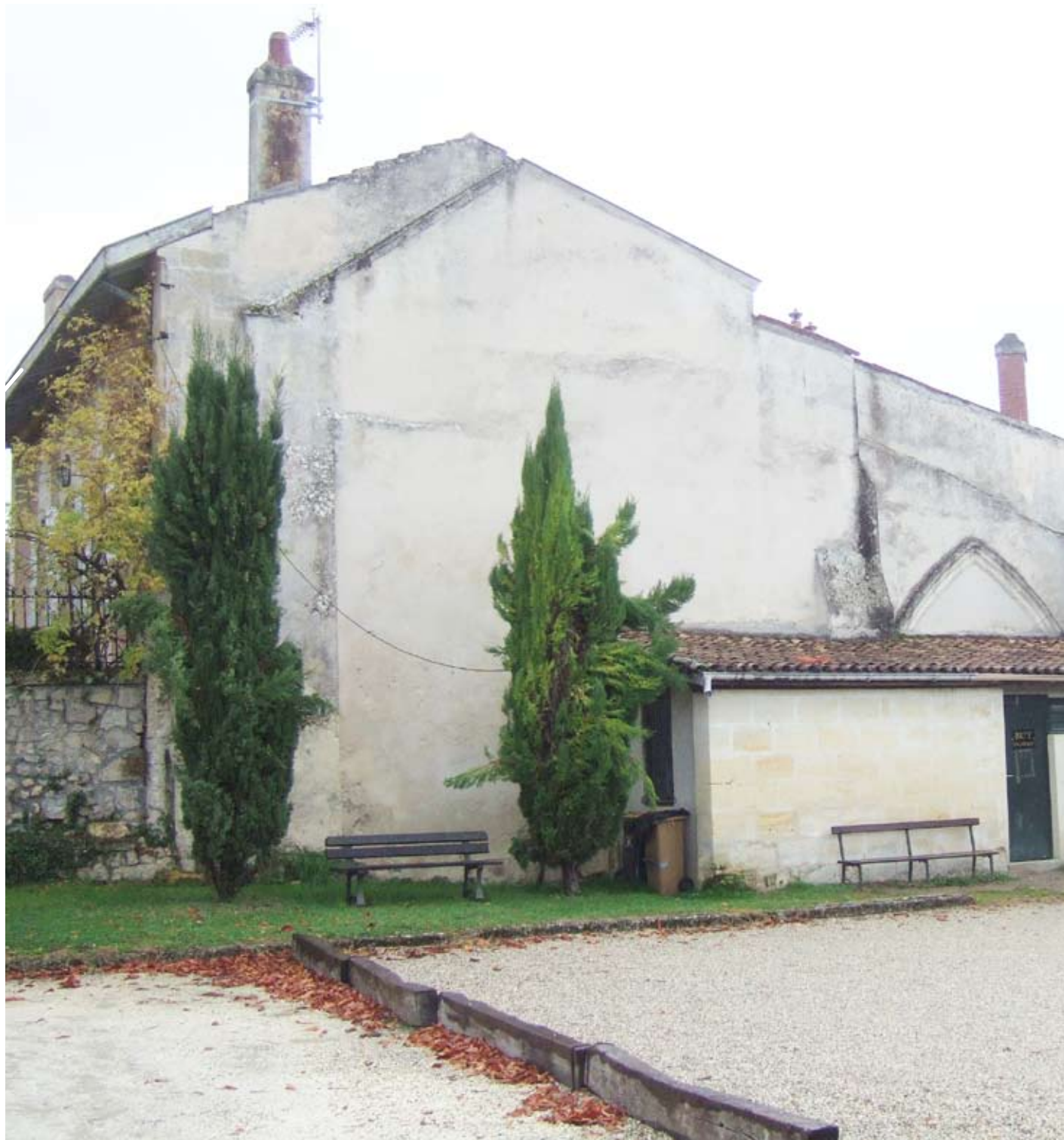
Façade Nord Est de l'église Saint Cyr et Sainte Julitte, toujours visible à ce jour place Carnot.
